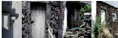
Caravelho - Desgradação do Parque Habitacional do Corvo
