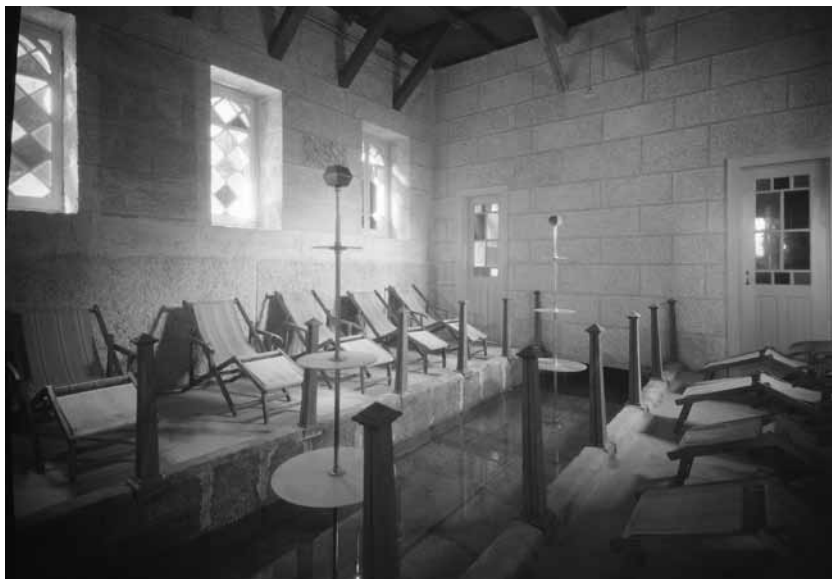
Fig. 4 – Sala do Emanatório das Termas Radium. Fotografia do Estúdio Mário Novais, Biblioteca de Arte da Fundação Calouste Gulbenkian.
