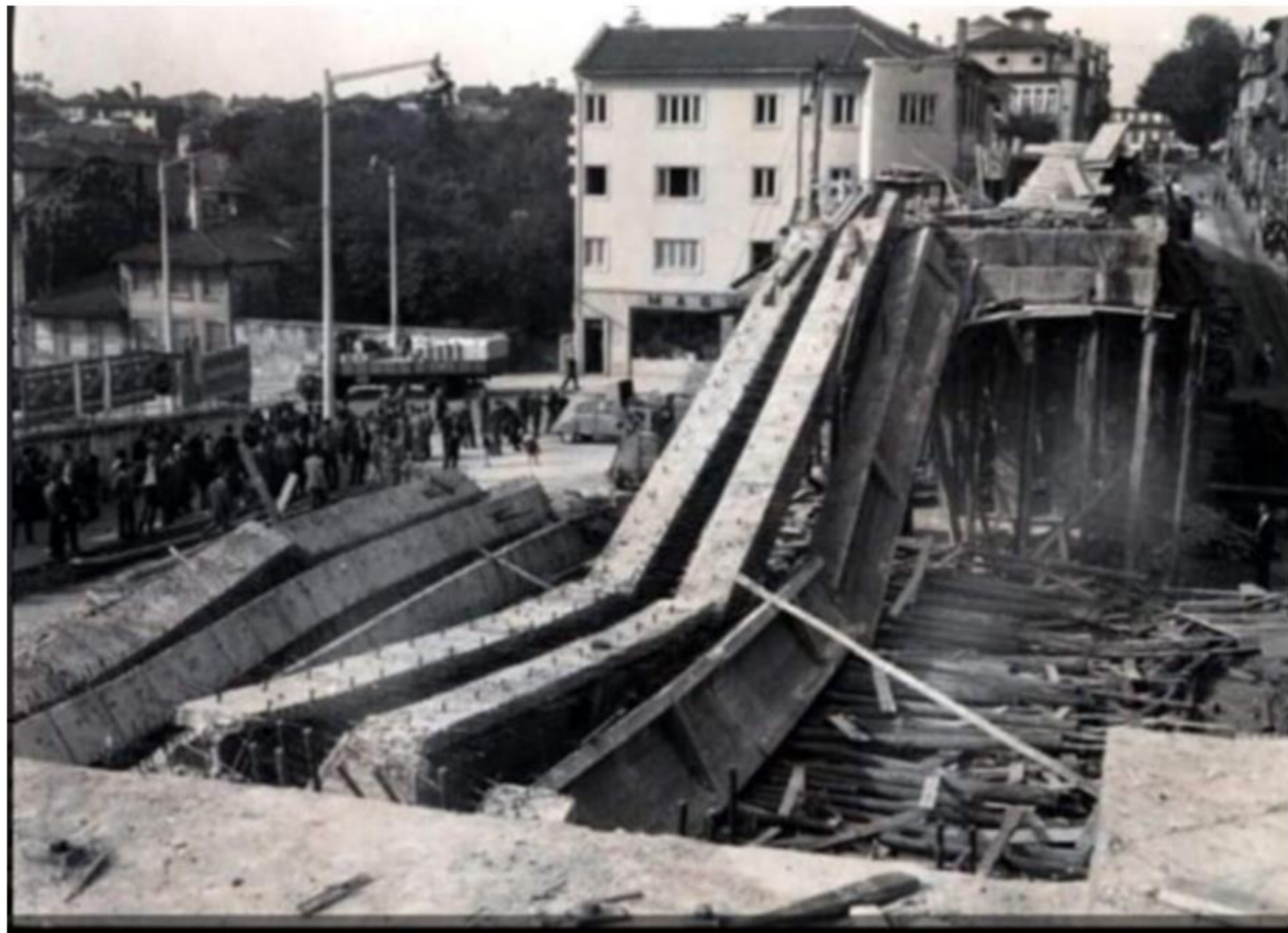
16 de Outubro de 1961 Desabamento do viaduto de Gonçalo Cristovão
