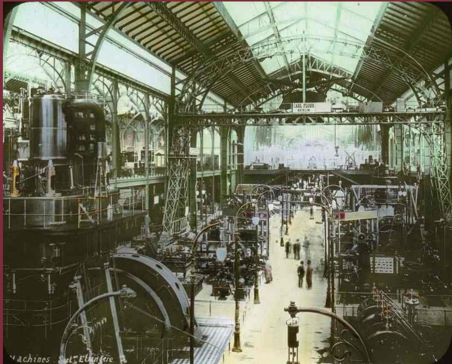
Interior del Palacio de la electricidad
