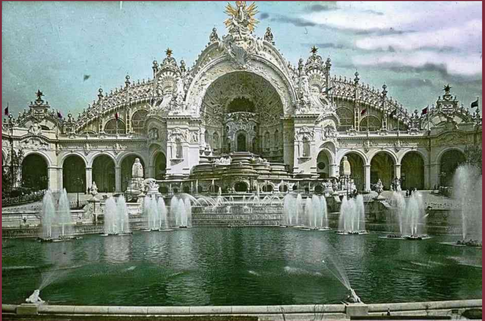
Palacio de la torre de electricidad y castillo de agua
