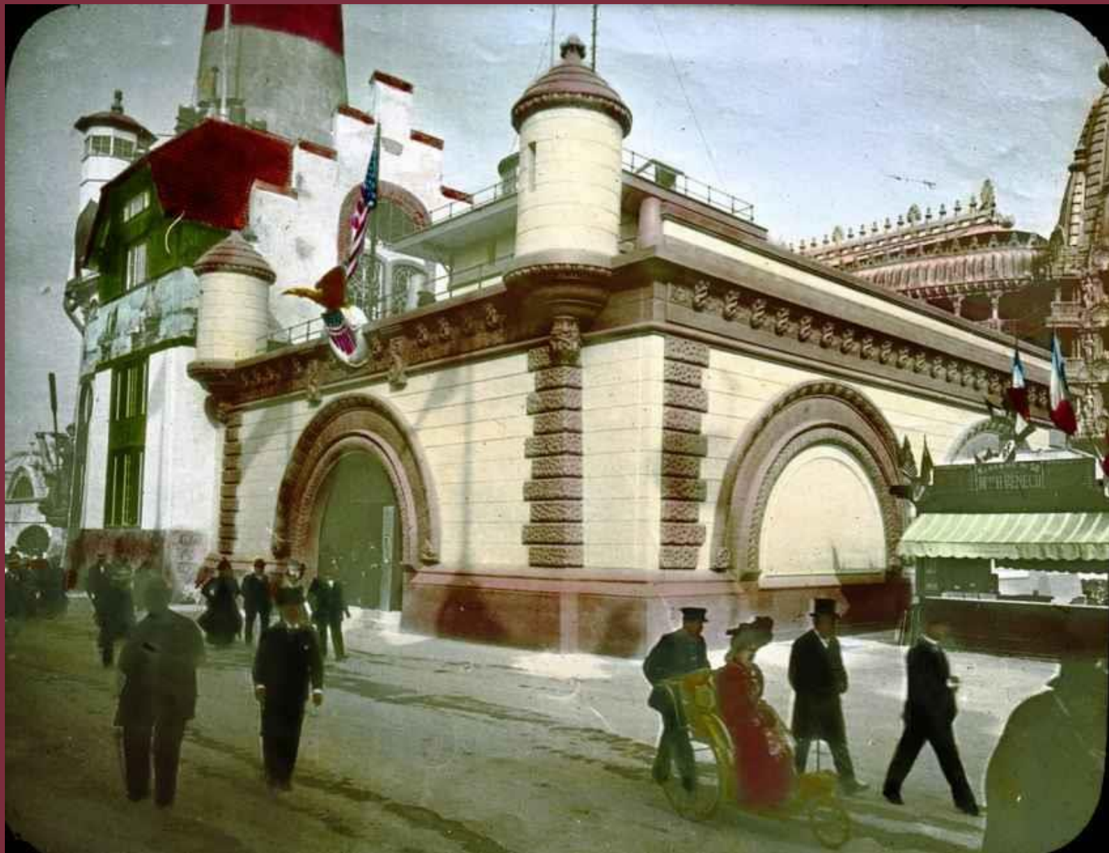
Edificio de la Marítima alemana
