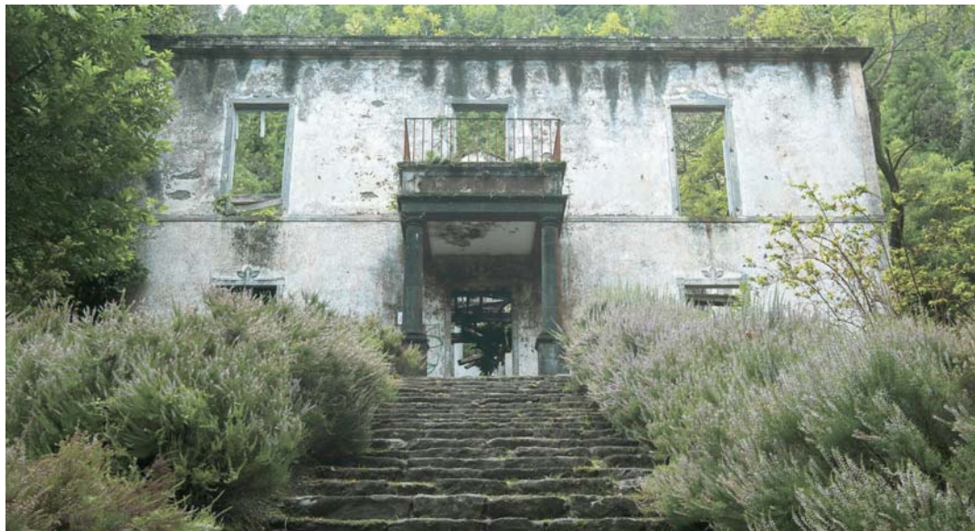
No futuro, a administração do parque natural irá procurar reabilitar as restantes estruturas que ali existem.
