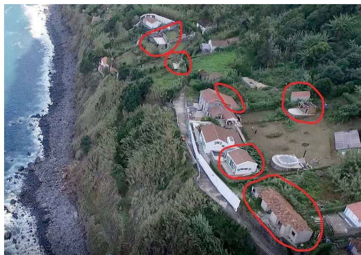
Esta foto de Outubro de 2018 evidencia o número de casas construídas em praticamente três anos
