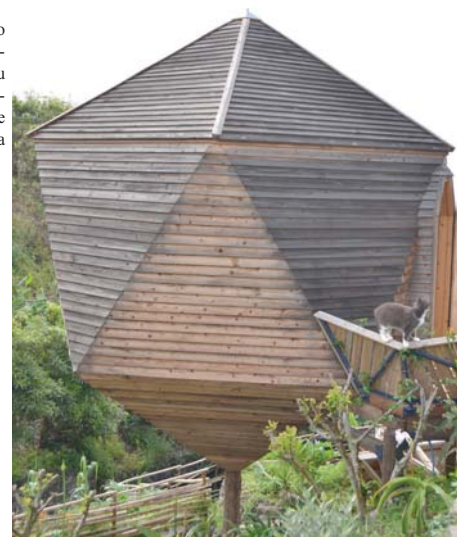
A base assenta num pilar construído a partir da reutilização de postes de electricidade de madeira
