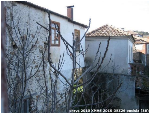
vista da figueira, já seca, nas traseiras em 2010
